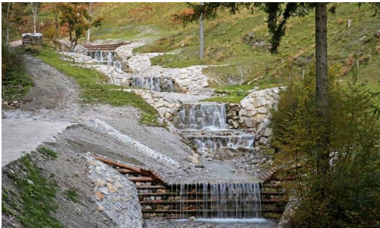
Pet stabilizacijskih pregrad na Blatnici v Klemenčevem in prečna lesena kaša
